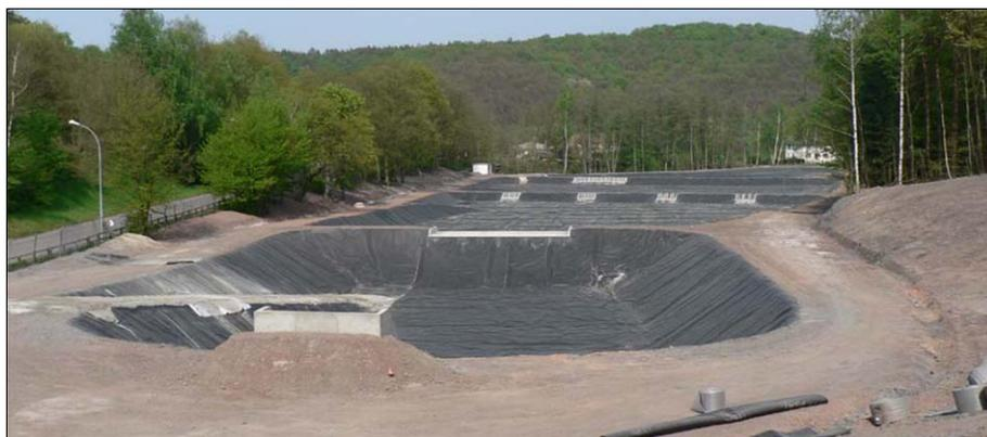
Figure 10. Pose des géosynthétiques
