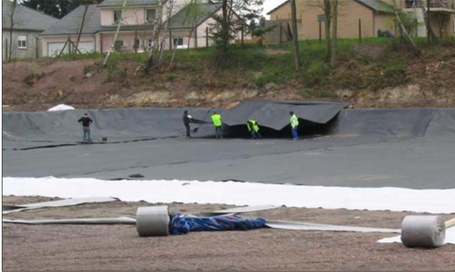
Figure 5. Pose des géosynthétiques
