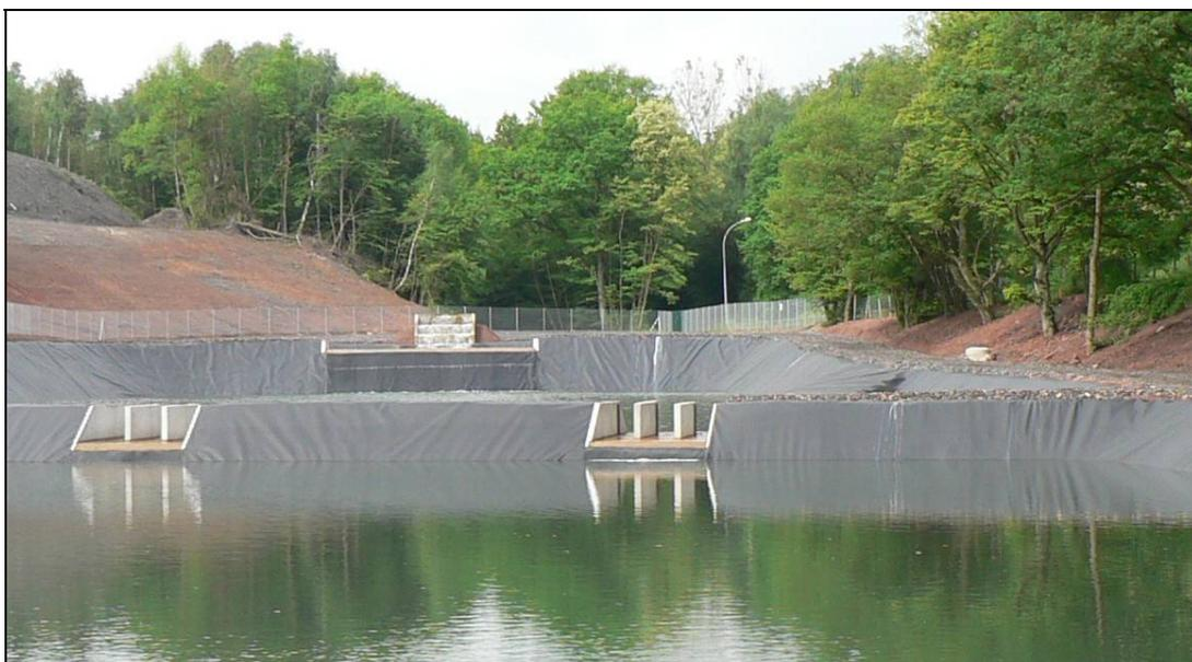
Figure 7. Vue de la première lagune en aval du bassin de décantation et ouvrages de surverse
