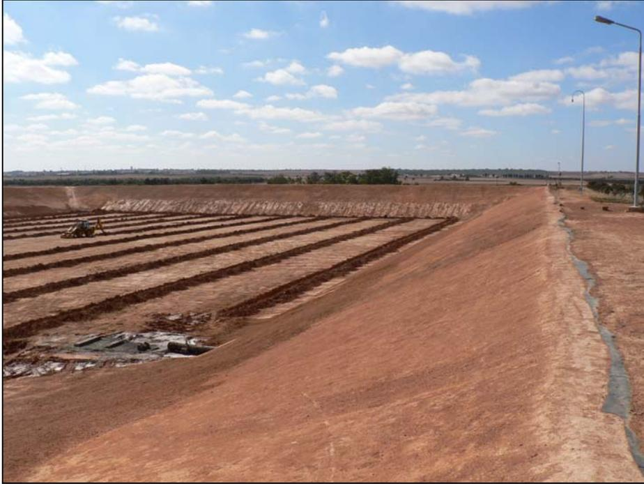
Figure 7. Préparation du fond de forme avec réalisation des tranchées drainantes
