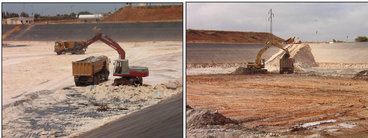
Figure 5. Extraction du sel dans la cuvette C1
