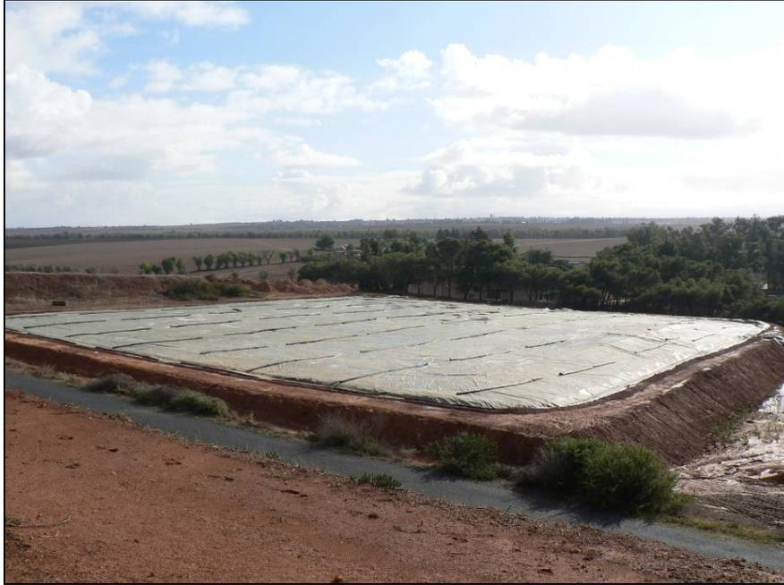
Figure 6. Aire de stockage du sel avec couverture en film PE
