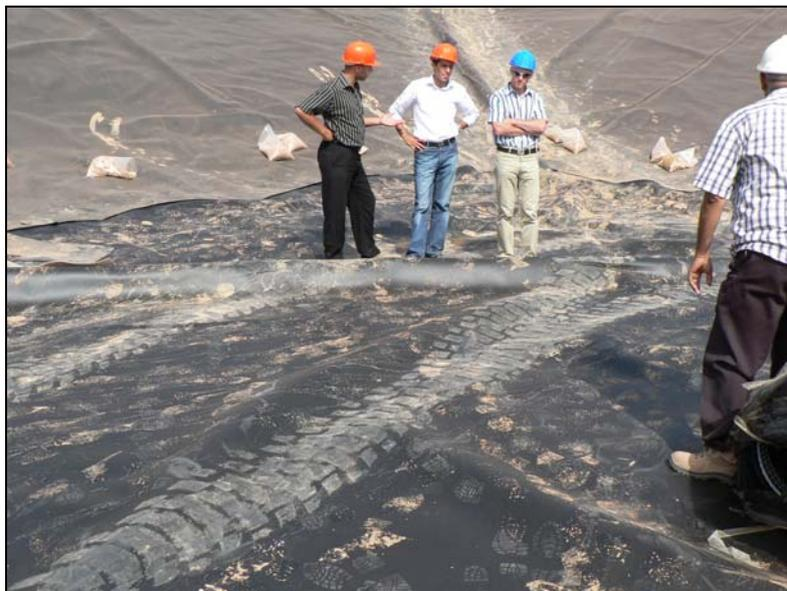
Figure 11. Endommagement de la géomembrane dû à la circulation d'un engin
