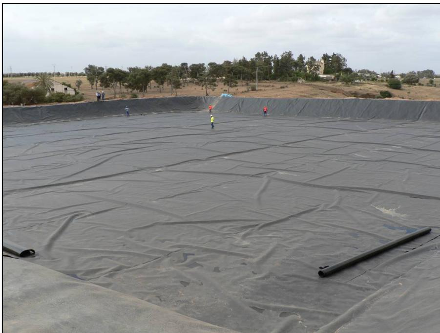
Figure 4. Aire de stockage pour le sel
