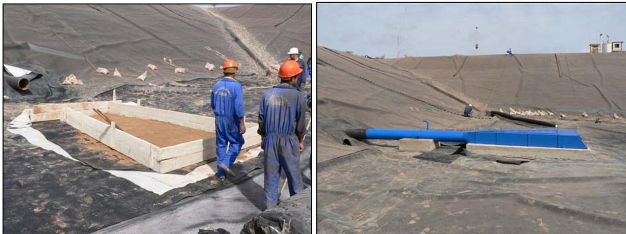
Figure 9. Traitement du point singulier de raccordement de l'étanchéité sur la tuyauterie 14" d'amenée de la saumure
