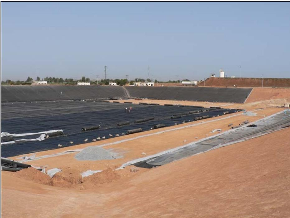
Figure 8. Pose de l'étanchéité par géomembrane PEHD 2 mm sur le géotextile anti-poinçonnant
