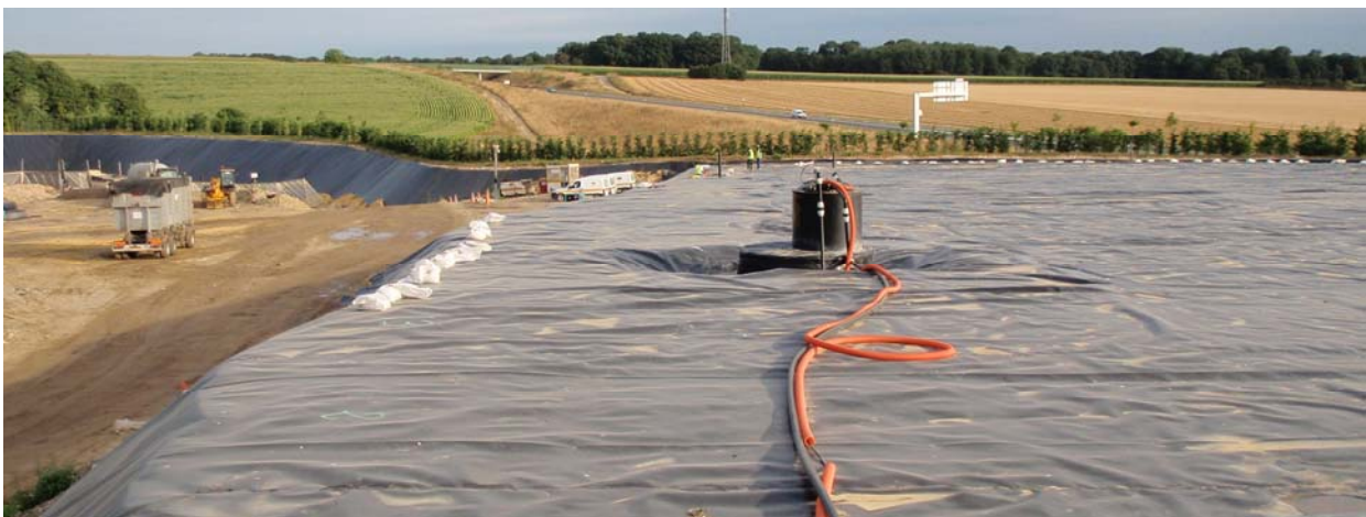
Figure 7. Mise en œuvre d'une couverture définitive
