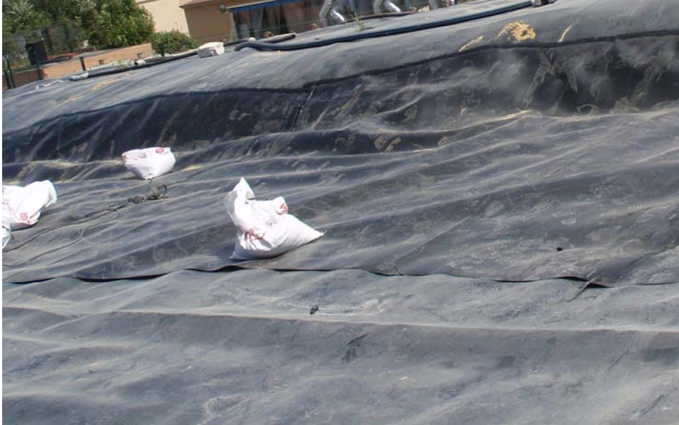
Figure 8. Mise en œuvre d'une bavette
