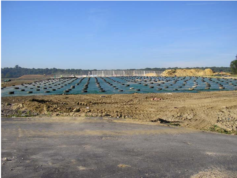
Figure 6. Mise en œuvre d'une couverture provisoire
