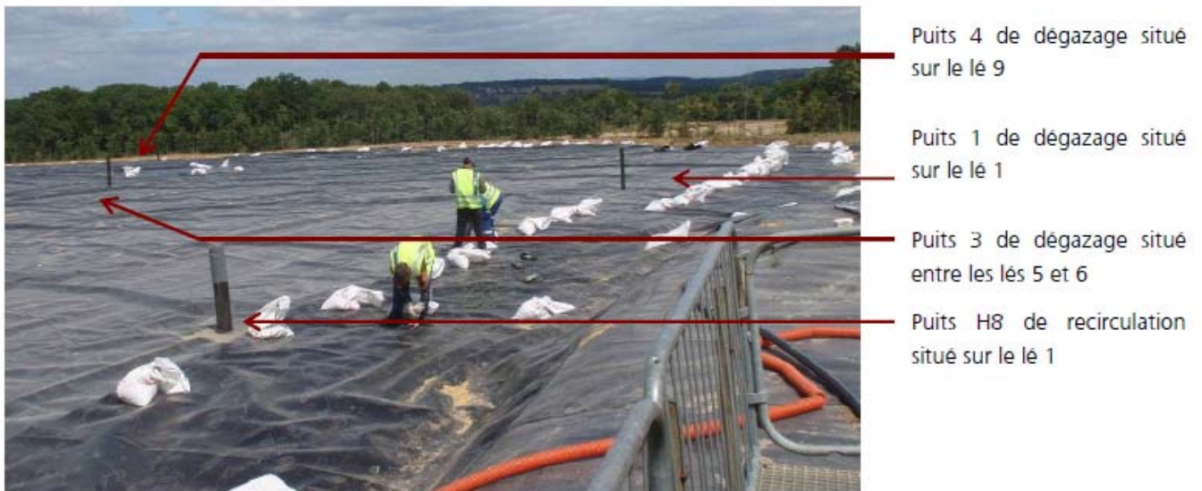
Figure 9. Mise en œuvre d'une bavette
