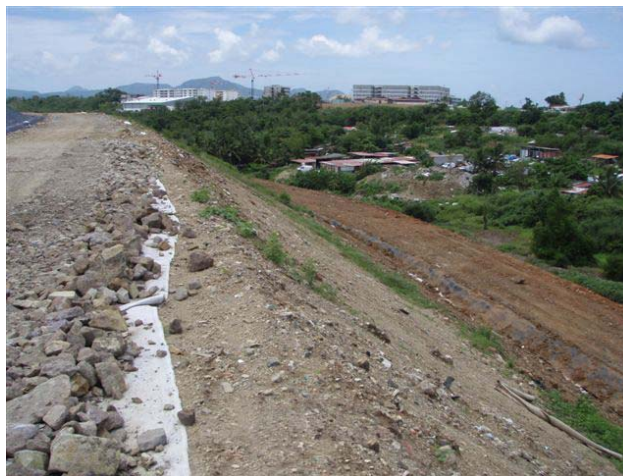
Figure 9. Couverture après mise en œuvre de la terre végétale
