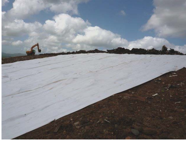
Figure 5. Mise en œuvre du géocomposite directement sur le sol de fermeture
