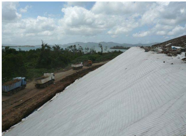
Figure 7. Mise en place de la géogrille de retenue des terres
