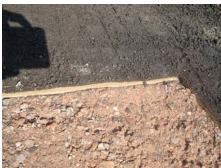
Figure 3. Vue de la tranche du GSB après prélèvement et du sol support sur l'ISD A
