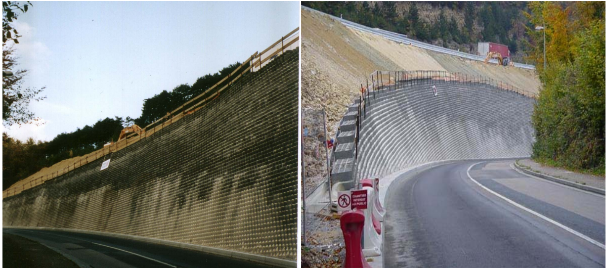
Figure 2. Photos du soutènement réalisé
