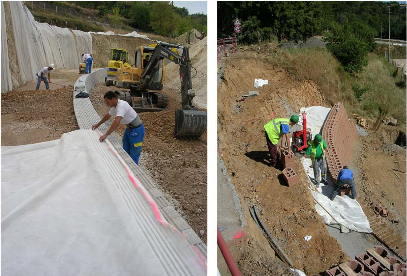
Figure 1. Mise en place manuelle des blocs sans apport de liant et du géotextile.
