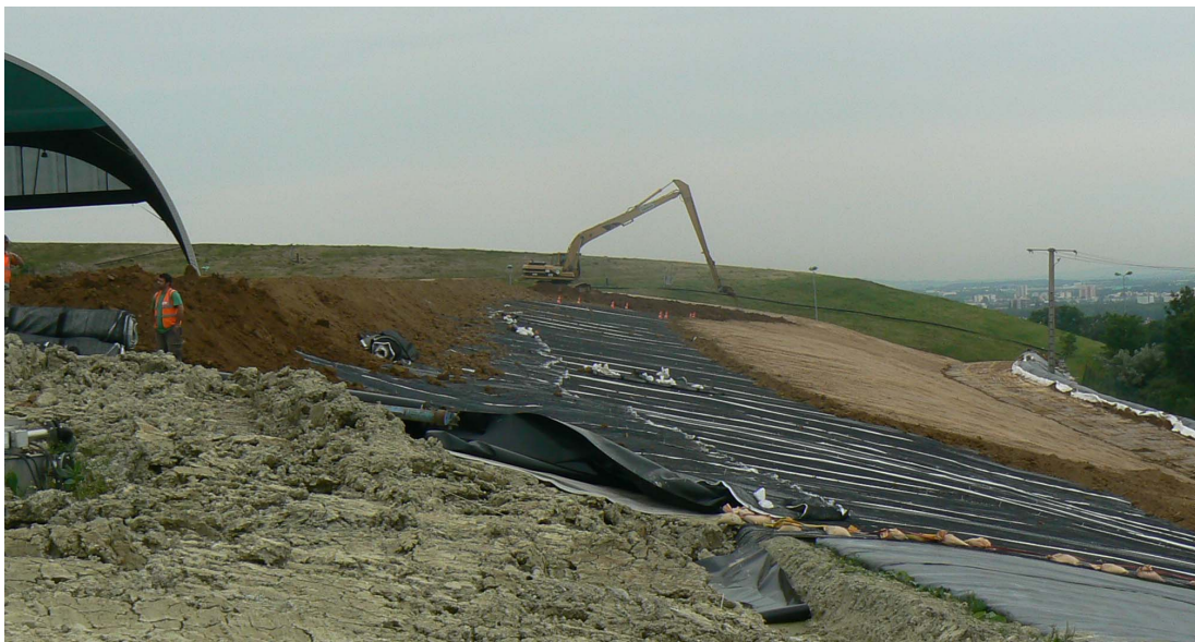
Figure 7. Mise en œuvre de la couche de recouvrement sur le DEG
