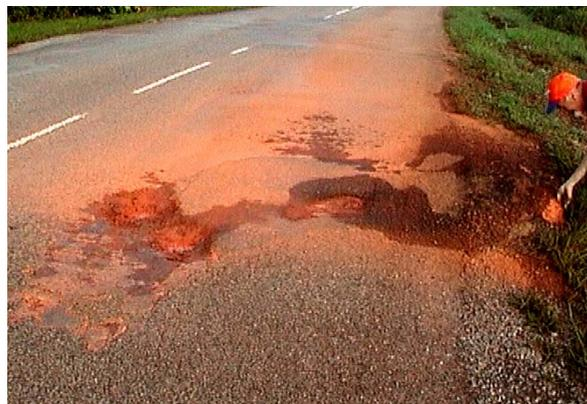
Figure 2. Dégradation en rive (19 ans de service)
