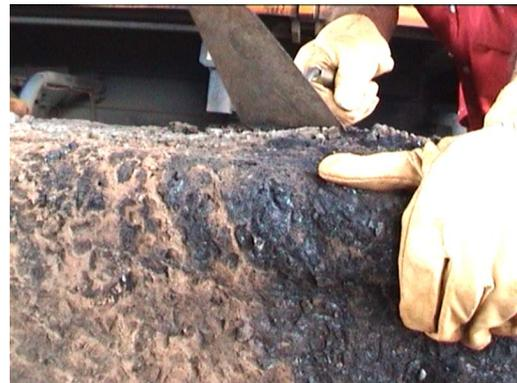
Figure 3. Aspect « gaufré » du géotextile saturé de bitume après suppression des gravillons 6/10 (RD 65)
