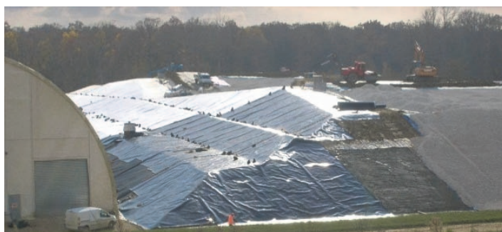
Figure 17. Étapes successives de mise en œuvre de la couverture (CSTFA).
