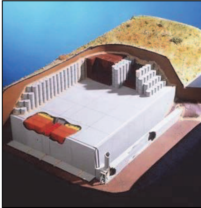
Figure 10. Vue en coupe d'une alvéole de stockage du CSM (Andra, 2009 a).
