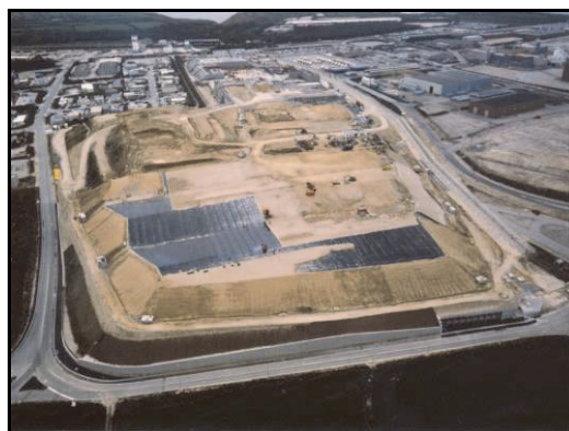
Figure 21. Vue générale de la construction de la barrière de couverture du CSM.
