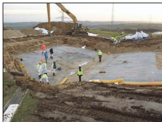
Figure 27. Excavation de la zone déformée jusqu'à la géomembrane supérieure avant réparation (CSM)
