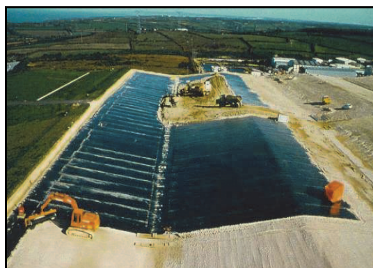
Figure 20. Mise en place de la géomembrane supérieure sur un panneau du CSM.
