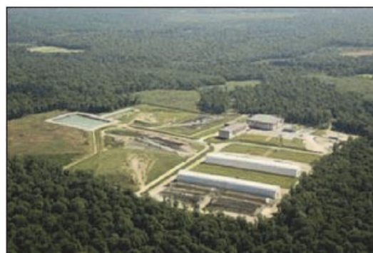
Figure 4. Vue aérienne du CSTFA (Aube).
