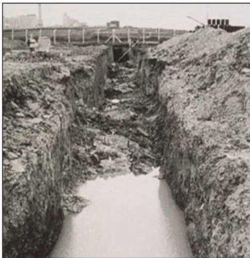
Figure 5. Tranchée en terre, pour le stockage initial dans les années 1970 (CSM)
