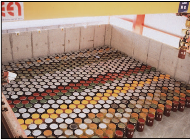
Figure 11. Alvéole en béton armé (CSFMA)
