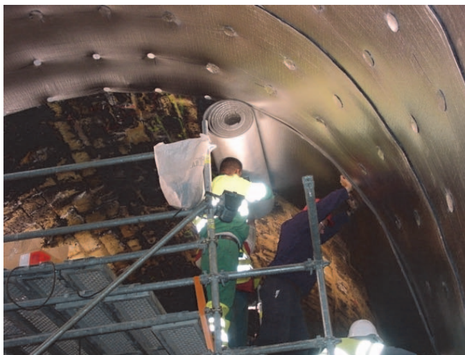
Figure 14. Pose d'un géocomposite de drainage apparent
