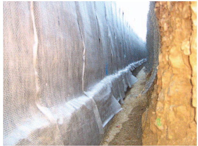
Figure 5. Drainage vertical par géospaceur
