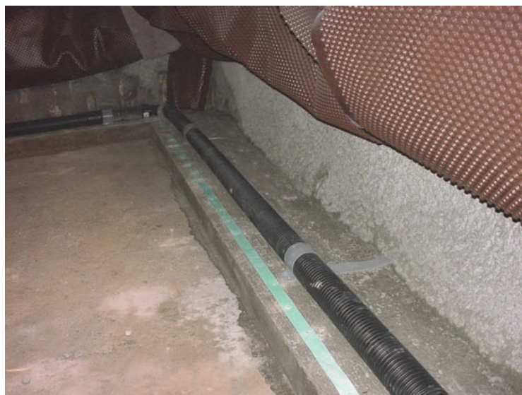
Figure 3. Raccordement de la lisse de drainage avec le drain
