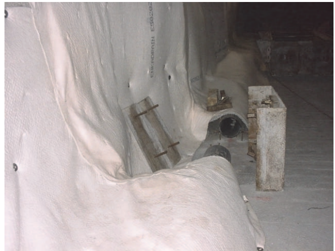
Figure 9. Raccordement de la géogrille au drain
