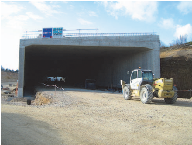
Figure 4. Tranchée couverte drainée
