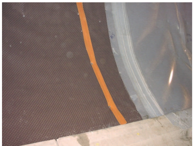
Figure 11. Raccordement géospaceur/DEG
