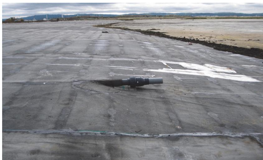
Figure 9. Facilité et efficacité en matière d'étanchéité du traitement des intrusions avec la géomembrane bitumineuse
