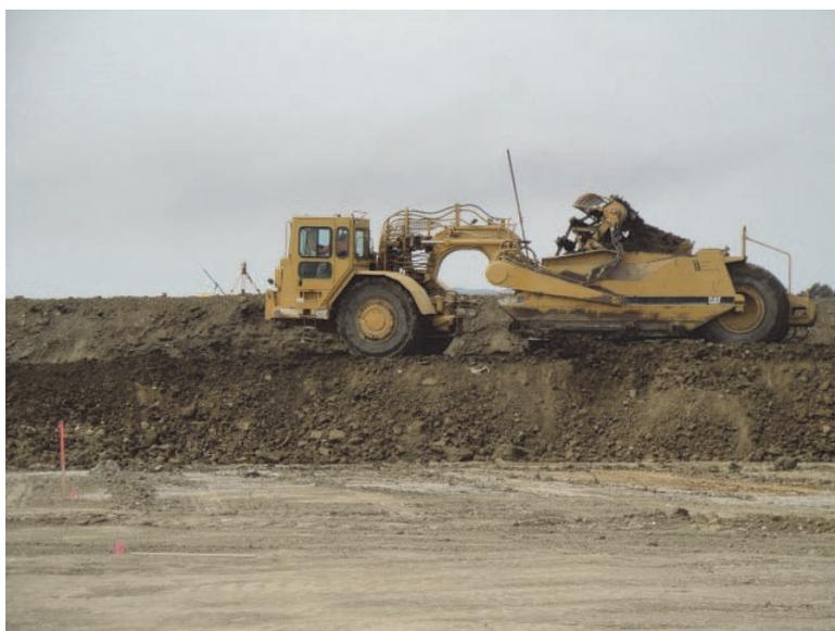
Figure 7. Travaux de terrassement. Noter la granulométrie des matériaux directement en contact avec la membrane
