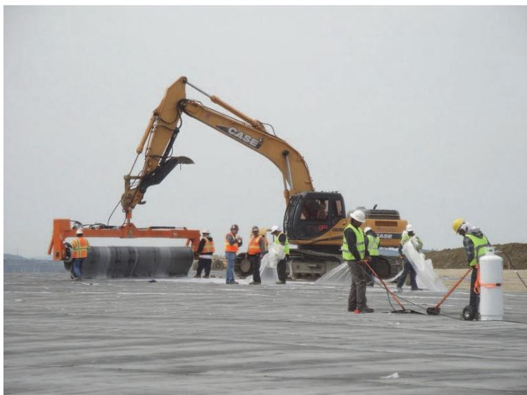
Figure 8. Déploiement de la géomembrane bitumineuse élastomère
