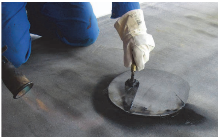
Figure 2. Exemple de réparation de géomembrane bitumineuse par ajout de patch (photo : Gisbert, 2011)
