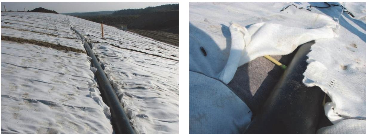
Figure 10. Dispositif de collecte des eaux pluviales sans tranchée collectrice.
