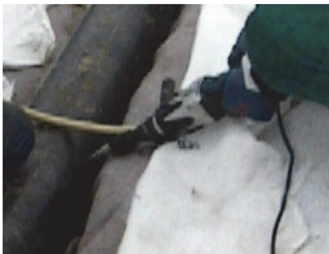
Figure 7. Perforation du drain collecteur plein.
