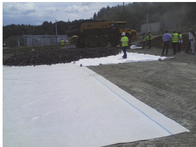
Figure 4. Planche d'essai in situ
