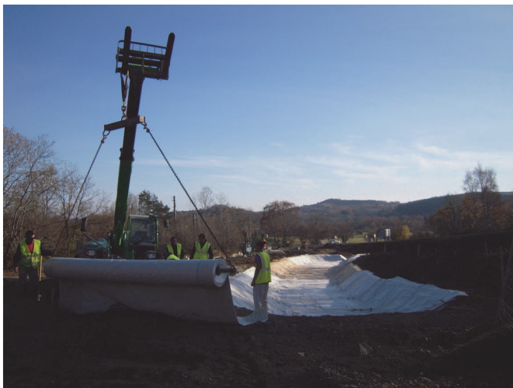
Figure 7. Mise en œuvre du GSB au palonnier
