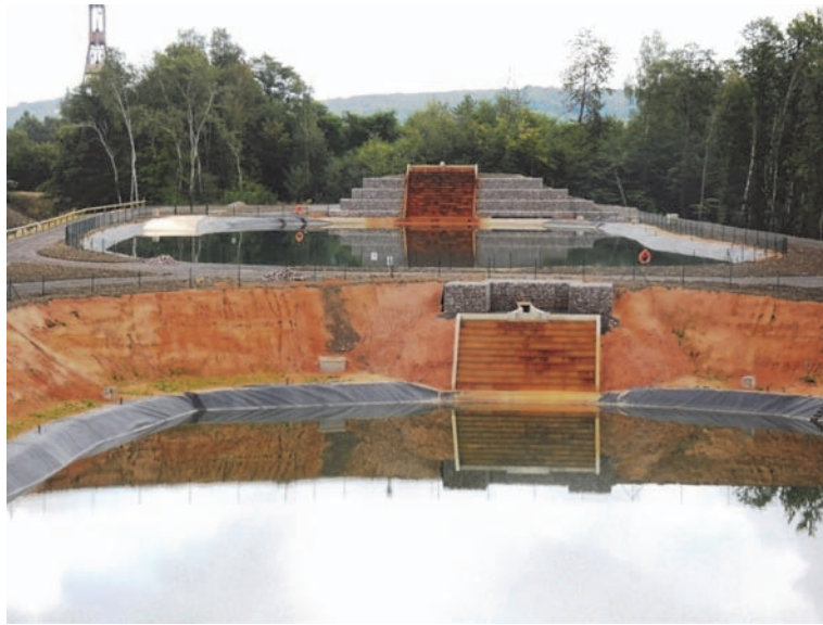
Figure 8. Ouvrages bassins 1 et 2 en phase d'essais hydrauliques
