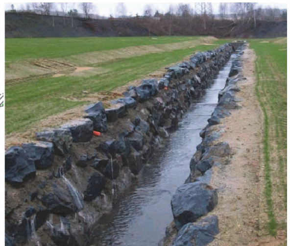
Figure 5. Coupe et photo du lit du Morsbach après travaux (source EnvirEauSol 2010)
