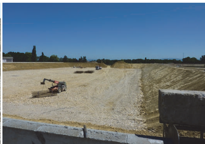
Figure 5. Vue générale des travaux de terrassement sur le nouveau bassin (bassin 5)
