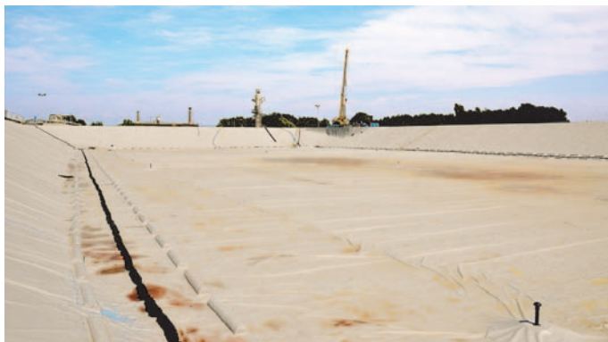
Figure 19. Bassin 2 en fin de travaux. On remarque : ligne de lest, lignes de flotteurs, événement
