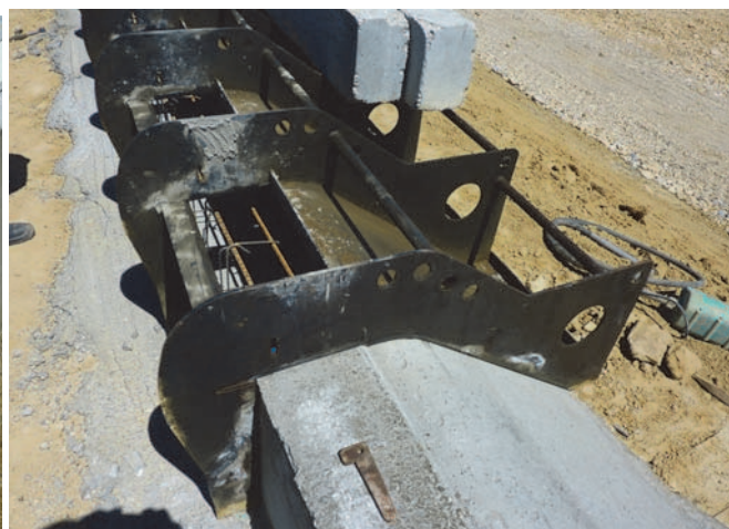
Figure 13. Détail de la longrine d'ancrage, montrant l'arrondi réalisé et le coffrage spécifique
