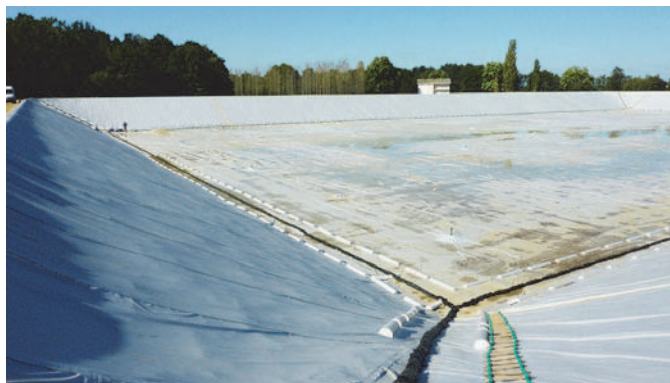
Figure 18. Bassin 5. Fin de la construction
