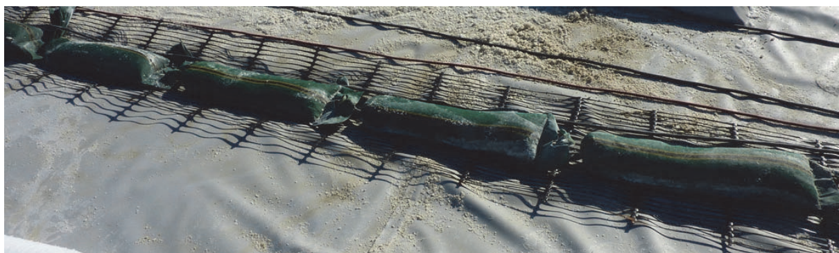
Figure 11. Vue du lestage au milieu des plis. La géogrille qui entourera les sacs assure la continuité et une relative perméabilité de la ligne de lest et sa tenue dans les pentes (angles des bassins)
