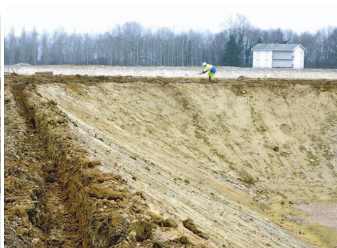
Figure 3. Aspect du même talus après préparation pour recevoir géomembrane et couverture
