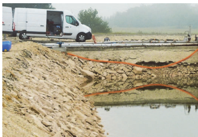
Figure 2. Talus du bassin 2 avant travaux
