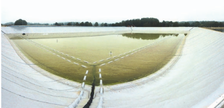
Figure 17. Bassin 3. Couverture en service
