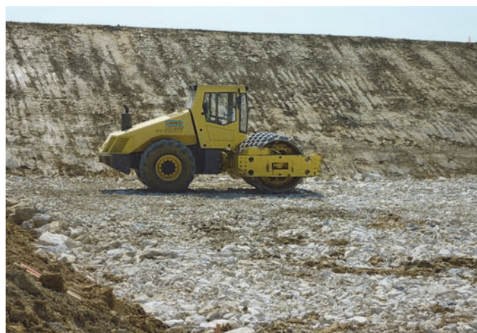
Figure 4. Compactage de 0,50 m de calcaire en fond de bassin et vue des talus préparés (bassin 5)
