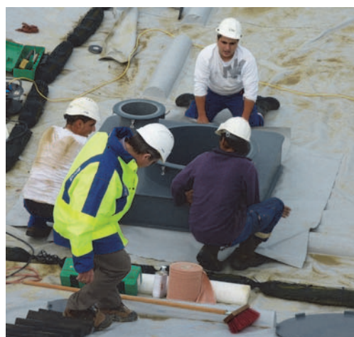
Figure 15. trappe d'accès en cours d'installation.
