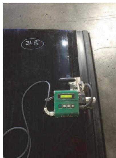
Figure 3. Soudure clé /Géomembrane
