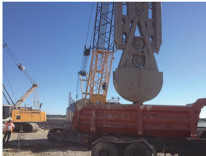
Figure 12. Benne à câble
