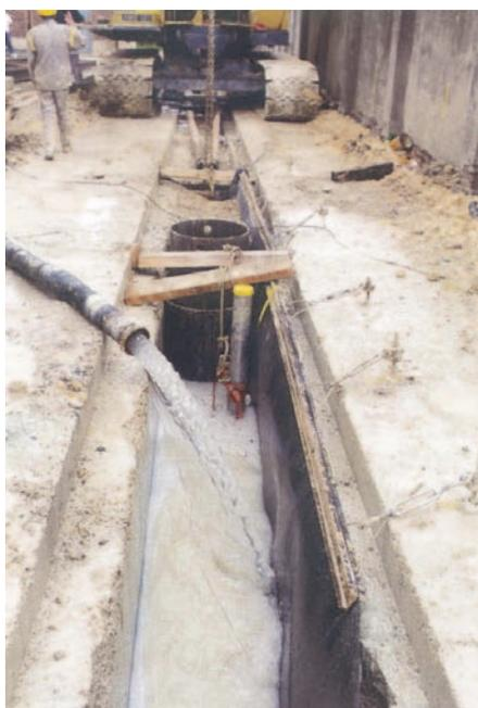
Figure 24. Vue de la tranchée drainante et d'un piézomètre
