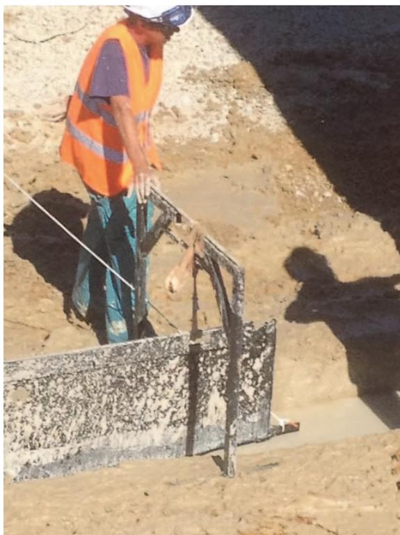
Figure 18. Chevalet + clé de contrôle
