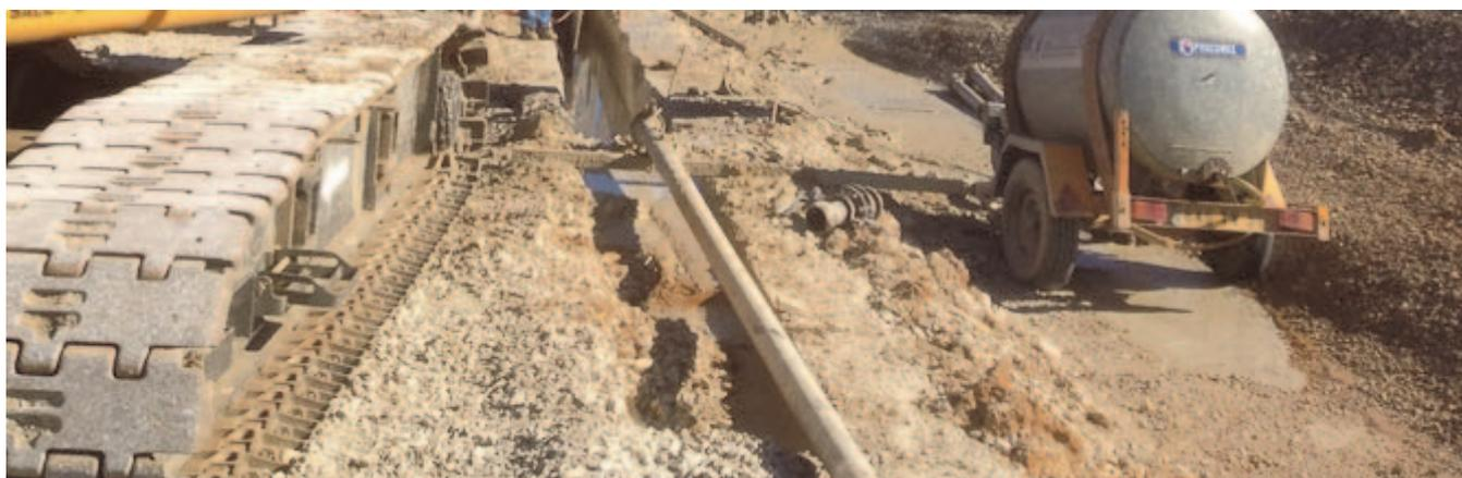
Figure 13. Tuyau alimentant la tranchée de bentonite ciment
