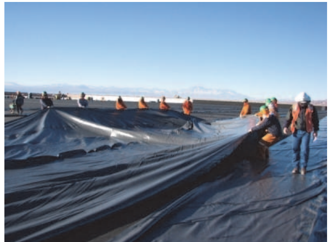
Figure 17. Déploiement d'un panneau de PVC
