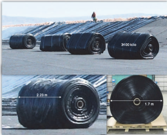
Figures 15 et 16. Dimensions typiques des rouleaux et profils de température en 2009
