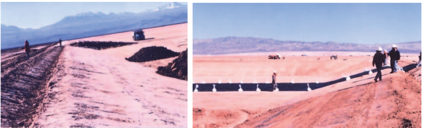
Figures 10 et 11. Construction d'un talus et mise en place d'un géotextile
