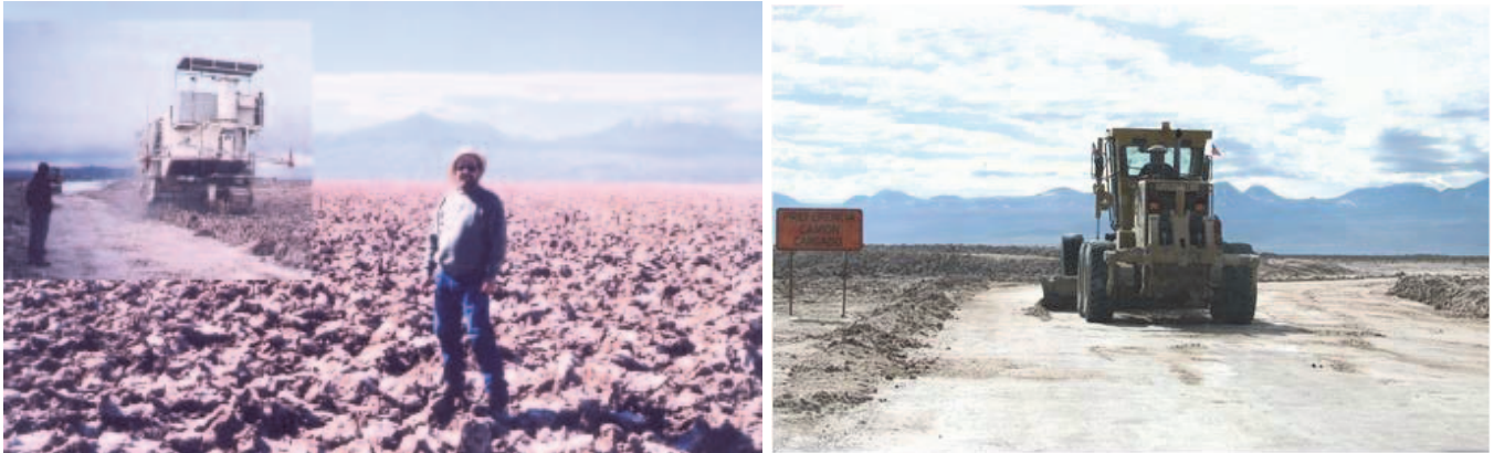
Figure 9. Préparation de l'assise
