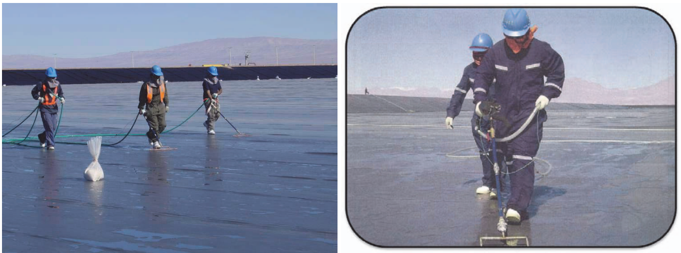
Figure 22. La détection de fuites par la méthode géoélectrique
