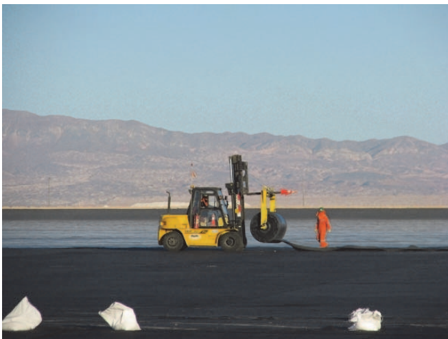
Figure 17. Déploiement d'un panneau de PVC
