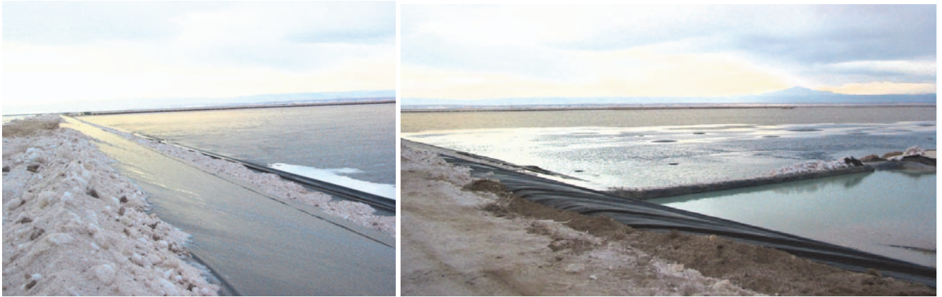
Figure 23. Démarrage d'un bassin
