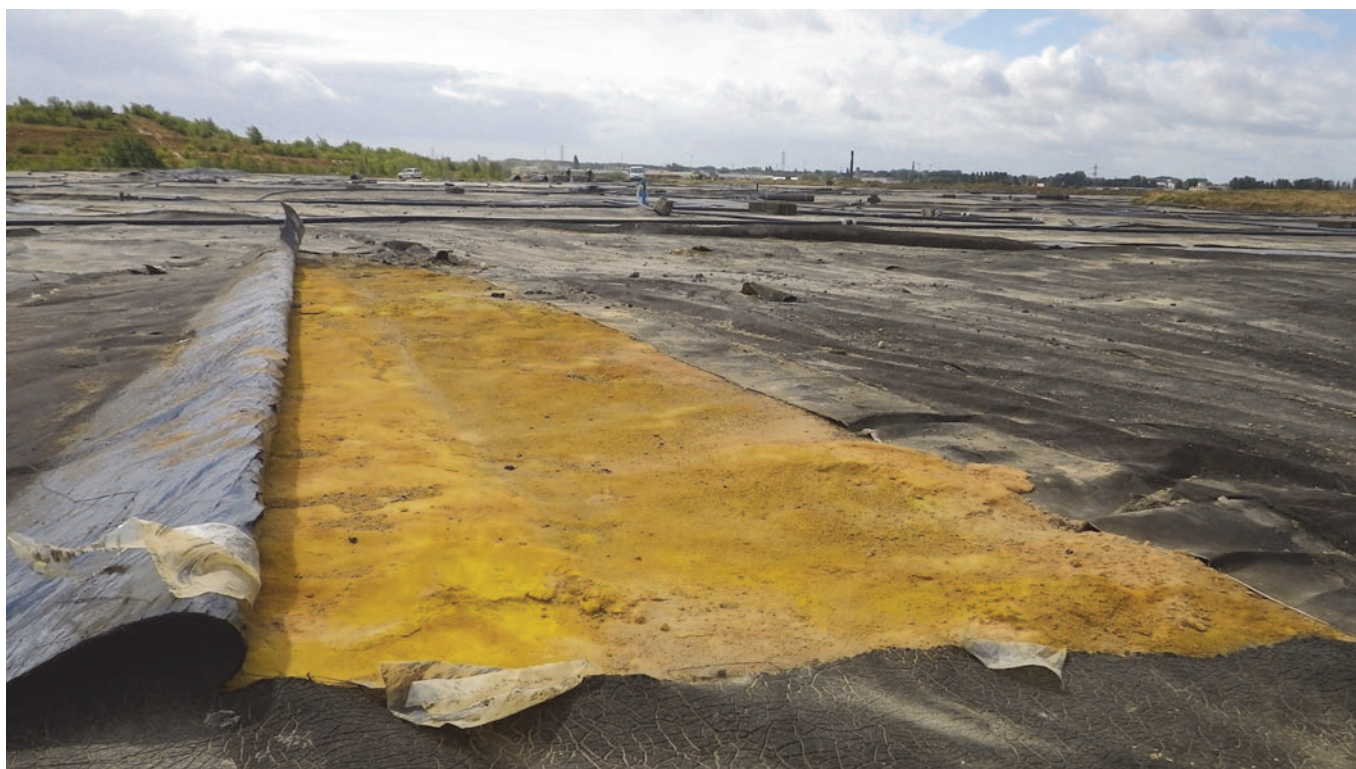
Figure 1. Vue de la géomembrane au contact des résidus
