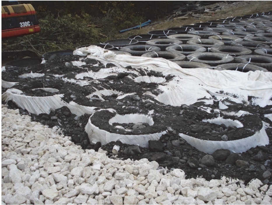
Figure 3. Mise en place du géotextile de renforcement, première couche sur la base drainante
