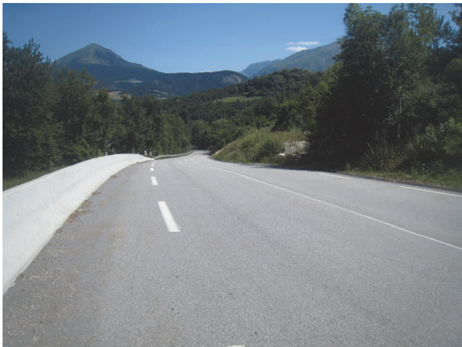
Figure 7. État de la chaussée au dessus du remblai allégé de type pneusol ; l'ouvrage se trouve en contrebas de la GBA
