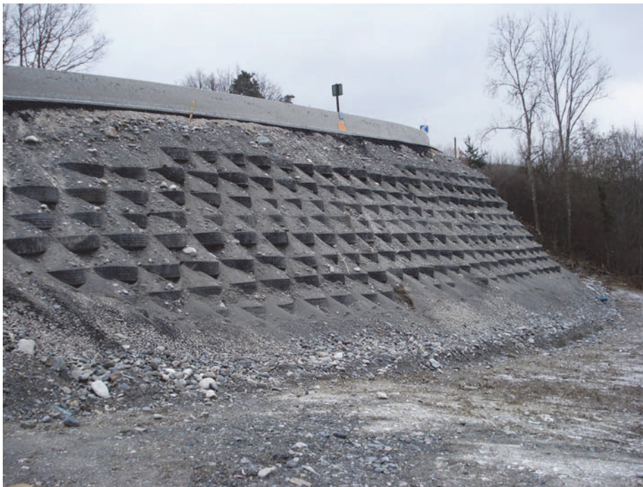
Figure 5. Ouvrage aval en pneusol allégé terminé
