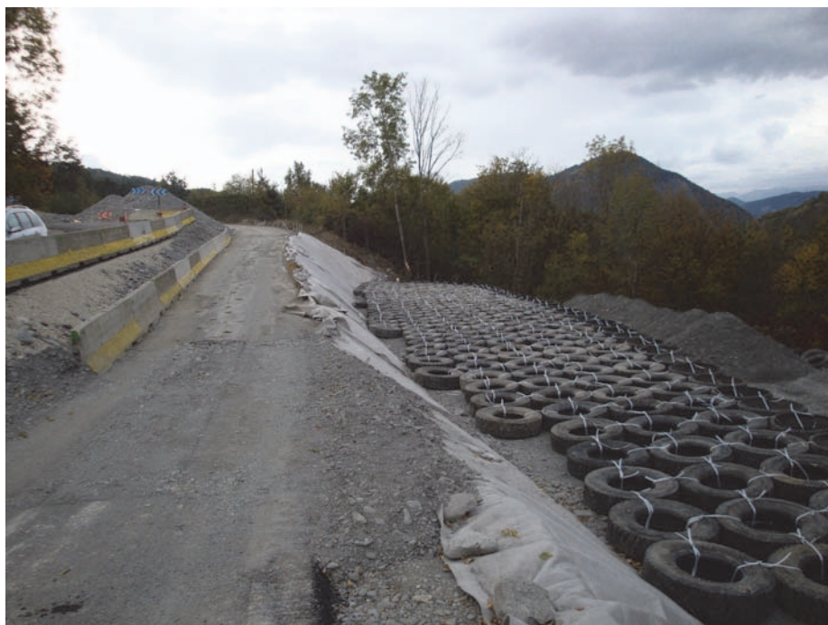
Figure 4. Réalisation du remblai en pneusol allégé, disposition des pneus
