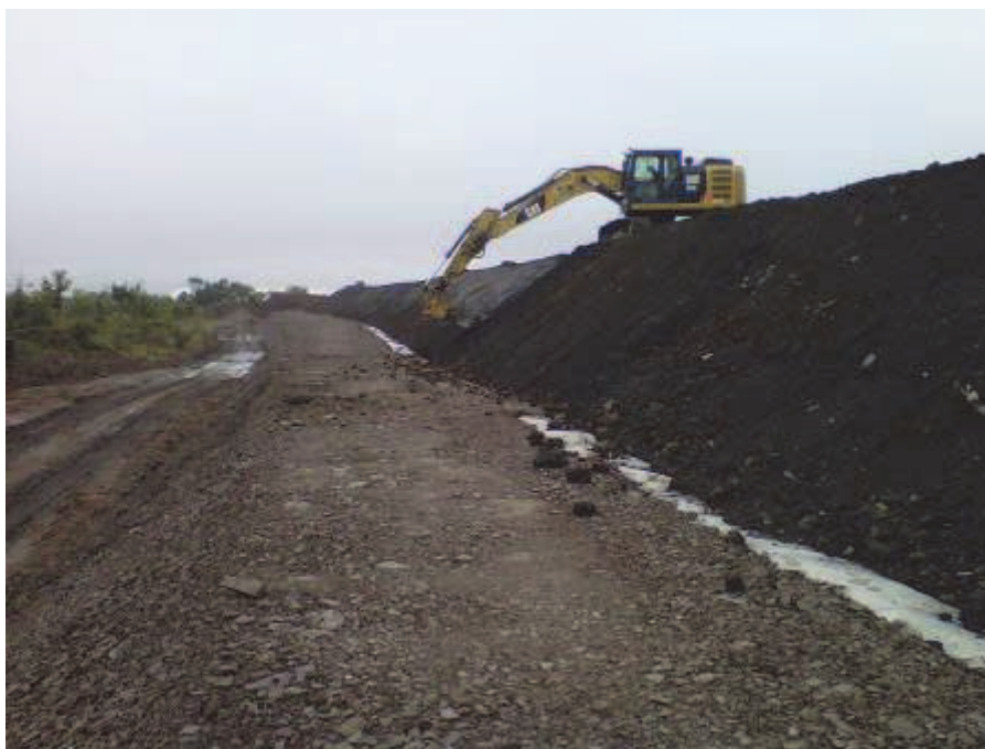
Figure 5. Modelage et lissage des résidus selon le profil de réaménagement final
