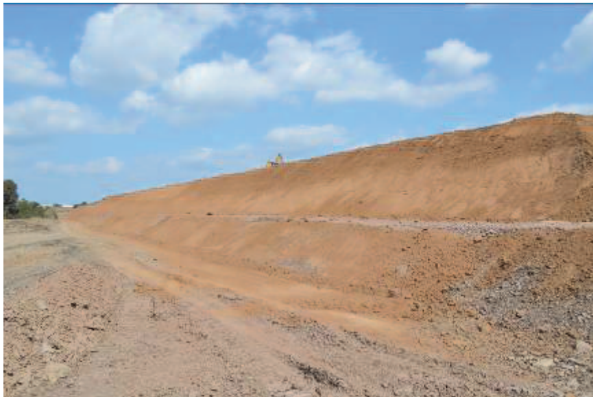
Figure 6. Mise en œuvre de la couche de limons pour constitution de couverture finale
