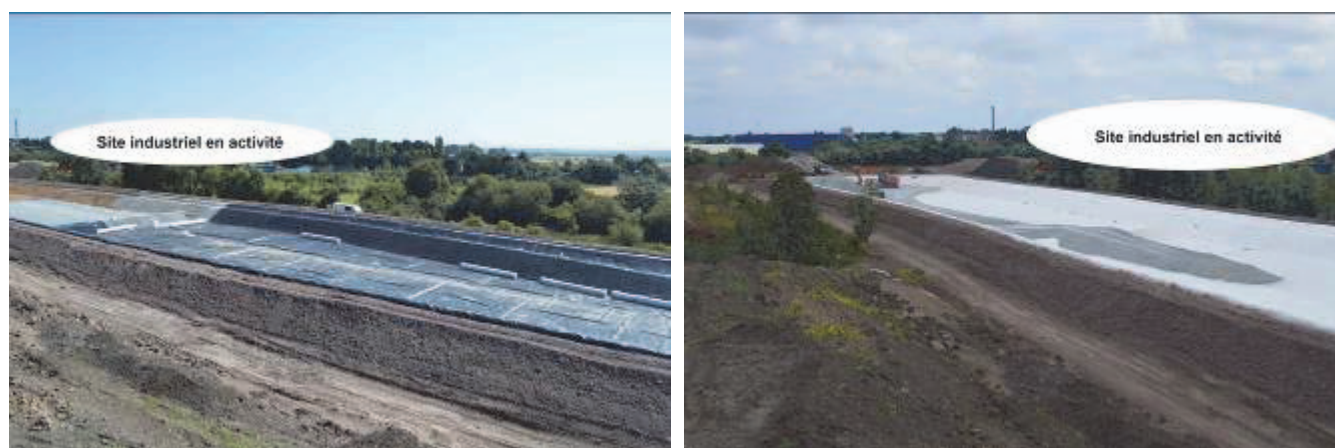
Figure 3. Application de l'étanchéité par géosynthétique et du niveau drainant
