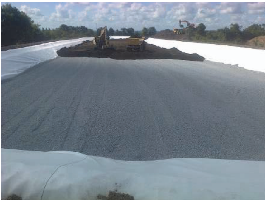
Figure 4. Déplacement des résidus vers le casier de confinement
