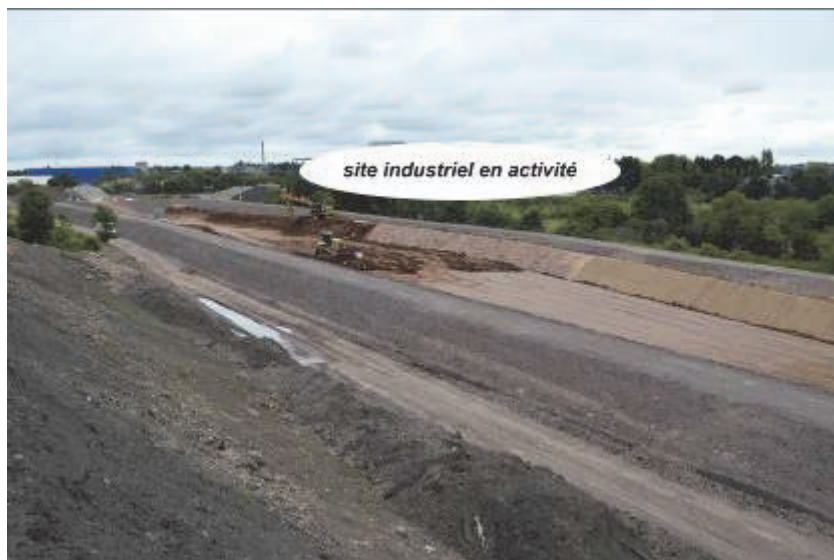
Figure 2. Mise en œuvre de la barrière passive reconstituée
