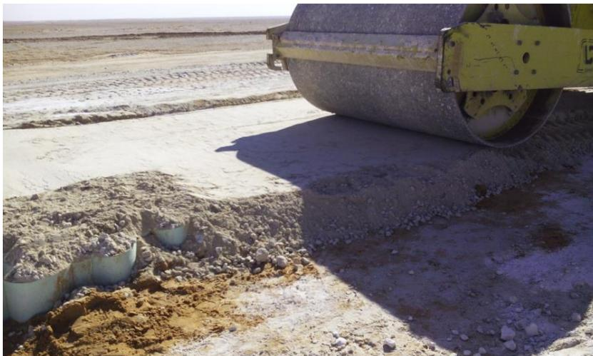
Figure 7. Mise en œuvre de la planche d'essai.
