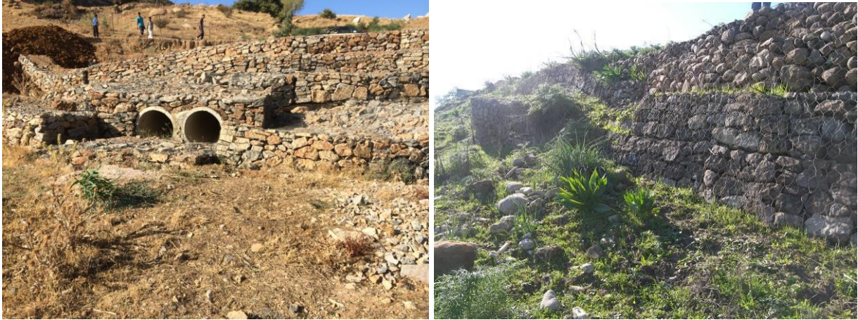
Figures 1 et 2. Exemples de traitement de butée en gabion
