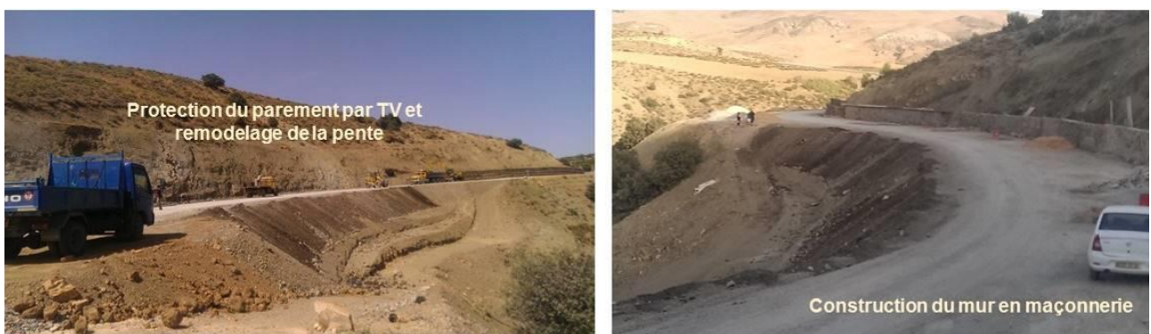
Figure 10. Protection du talus contre les UV et construction du mur en maçonnerie
