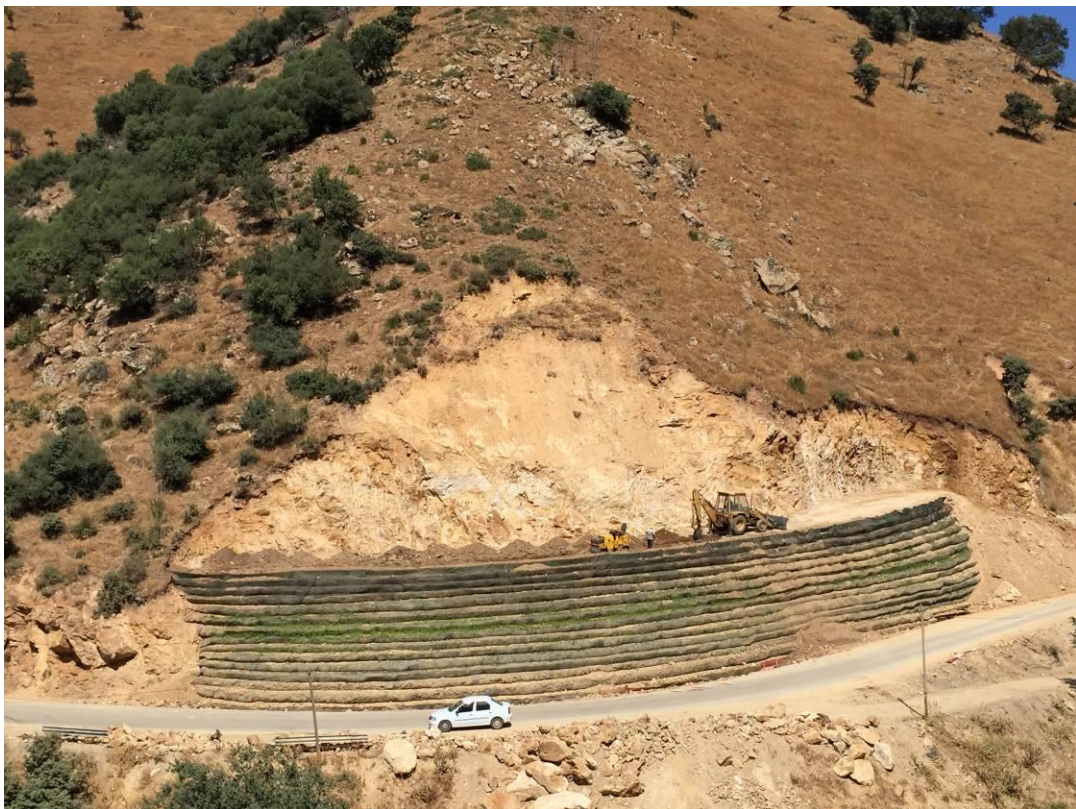
Figure 17. Construction du massif renforcé par géogridde FORTRAC et compactage des couches
