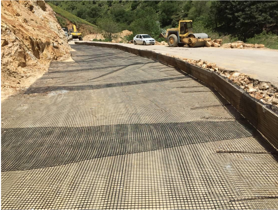
Figure 16. Construction du massif renforcé par géogridde FORTRAC et compactage des couches
