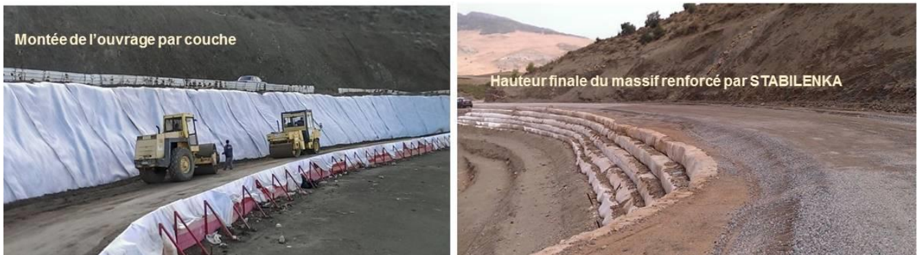
Figure 9. Construction du massif renforcé par géotextile
