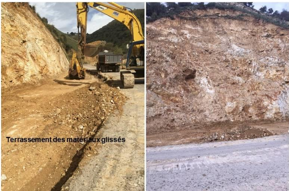
Figure 15. Purge des matériaux glissés et terrassement
