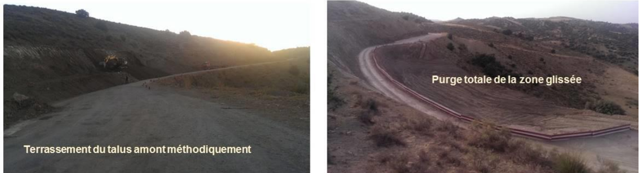
Figure 7. Élargissement de la chaussée et purge des matériaux glissés
