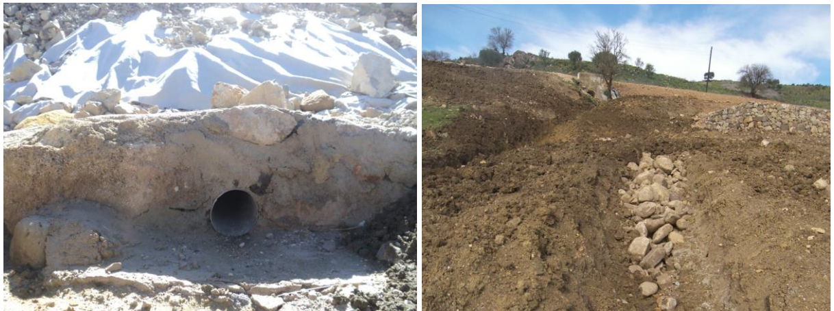
Figures 3 et 4. Exemples de traitement mis en place – éperon et tranchée drainante
