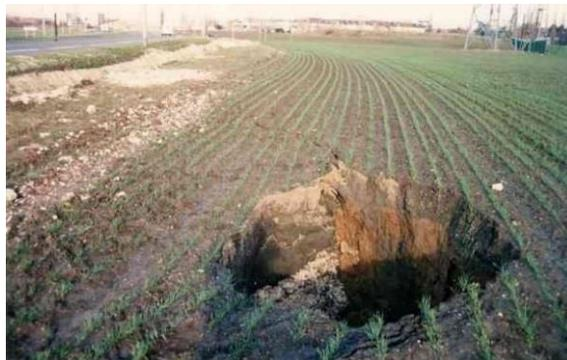
Figure 1. Exemple d’effondrement d’une cavité souterraine à Lille Hellemmes (Source SDICS/SEISM).
