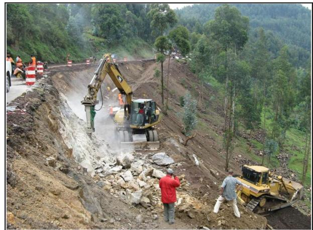
Figure 6. Excavation de la pente existante.
