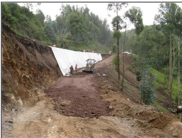
Figure 7. Géotextile de séparation et filtration
