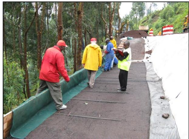
Figure 8. Installation de la géogrille et du géotextile.
