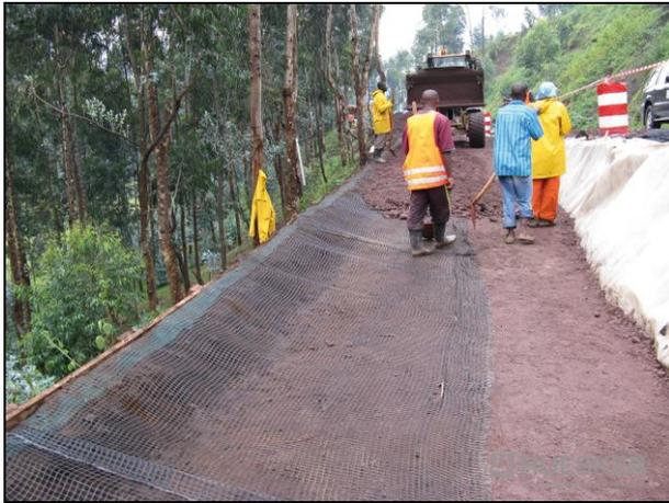
Figure 9. Ancreage du géogrille par retournement
