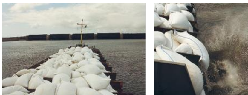
Figure 10. Stabilisation de l'affouillement en utilisant une barge pour le déversement des conteneurs (Saathoff & Witte, 1994).
