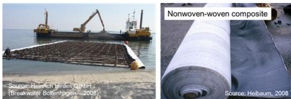
Figure 4. Immersion des fascines pour la stabilisation des épis.
