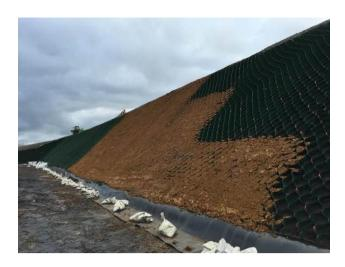
Figure 7. Planche d'essais du géocomposite alvéolaire – décembre 2015.
