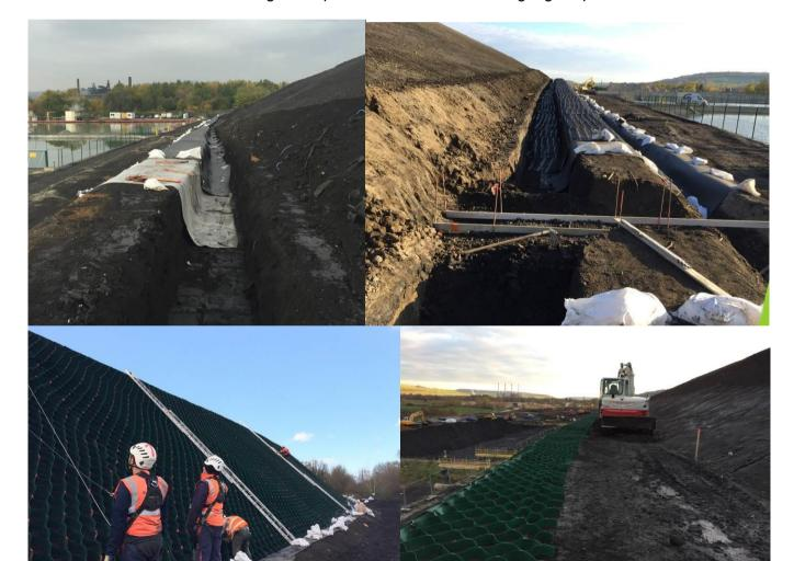
Figure 5. Mise en œuvre des géosynthétiques de la couverture équivalente du talus 1H/1V.
