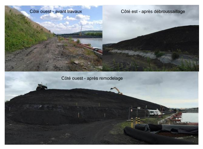
Figure 1. Photographies du stock de boues dans son état initial, suite au débroussaillage et après remodelage.
