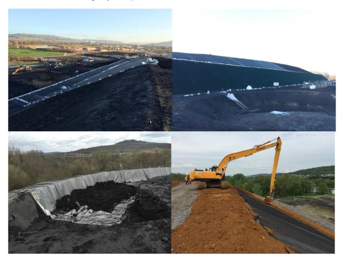
Figure 6. Mise en œuvre des géosynthétiques et de la terre végétale de la couverture équivalente du talus 2H/1V.
