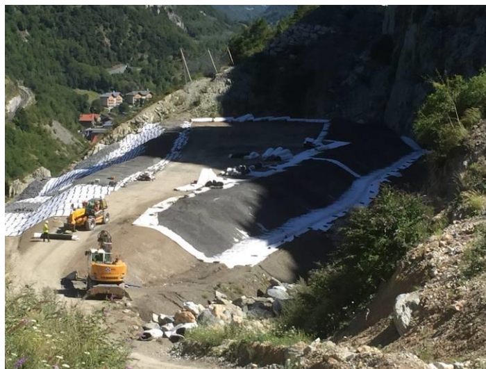
Figure 8. Vue d'ensemble du chantier
