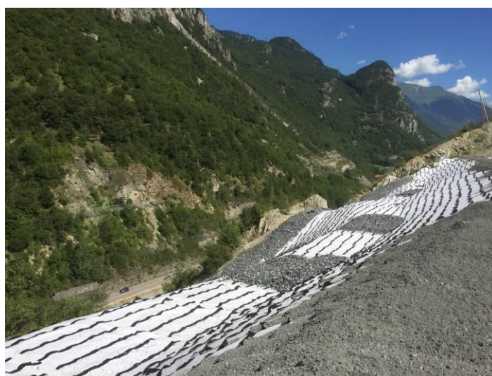
Figure 9. Mise en place des matériaux sur le géocomposite
