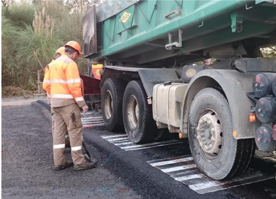
Figure 1 : Réalisation des planches expérimentales : circulation de camion sur les grilles.
