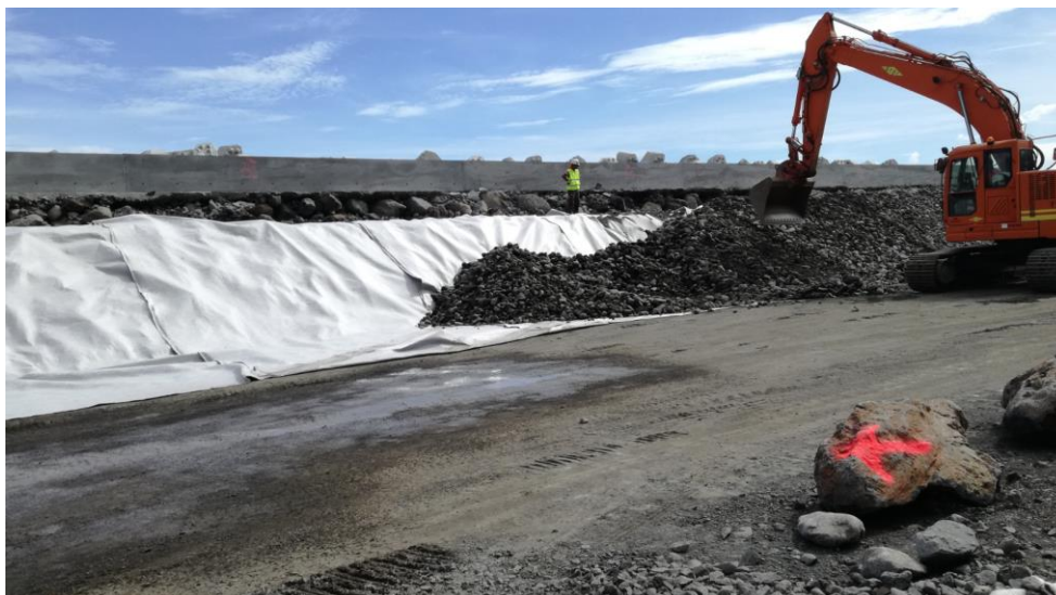
Figure 13. Mise en œuvre du géotextile filtrant à l'interface noyau / remblai 0/300
