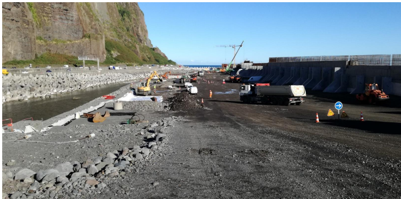
Figure 11. Vue générale des travaux de la partie supérieure de la digue
