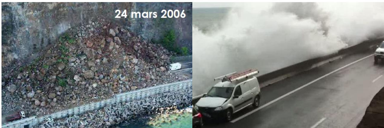
Figure 1. Risques naturels de la route actuelle : éboulements et houle cyclonique
