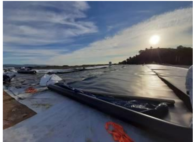
Figure 9. Prises de vues du chantier pendant la pose du complexe d'étanchéité
