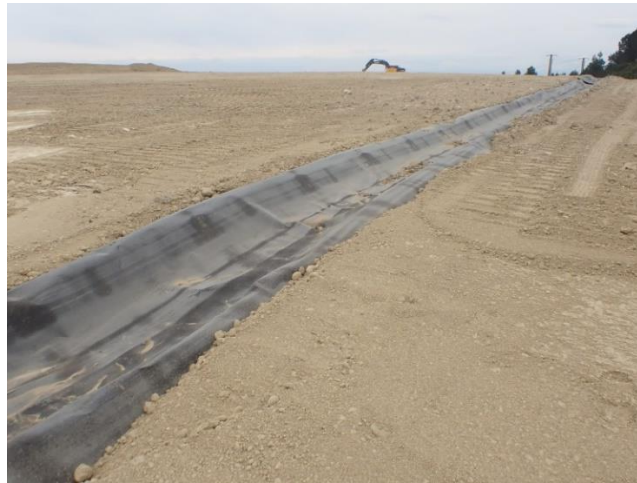
Figure 11. Fossé de surface étanché avec une géomembrane bitumineuse
