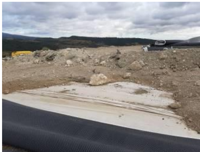
Figure 6. Matériaux de recouvrement sur le débord laissé en attente pour le raccordement
