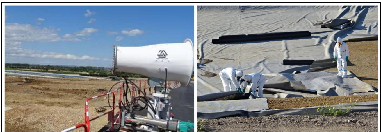
Figure 2. Chantier de terrassement avec brumisateurs et de pose des géosynthétiques avec protection du personnel
