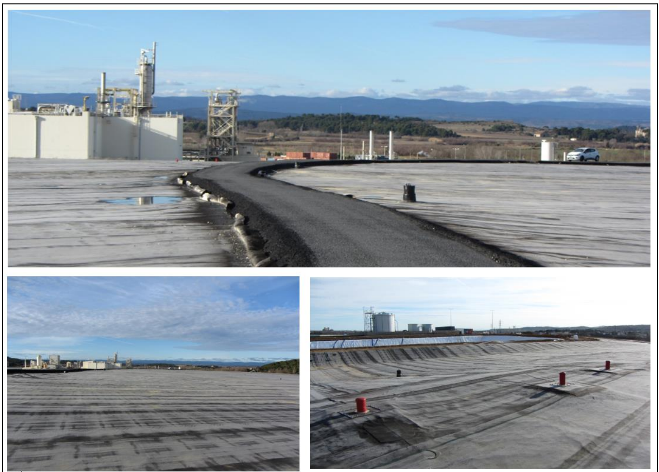
Figure 8. Aspect final de la couverture de l'INB en géomembrane bitumineuse
