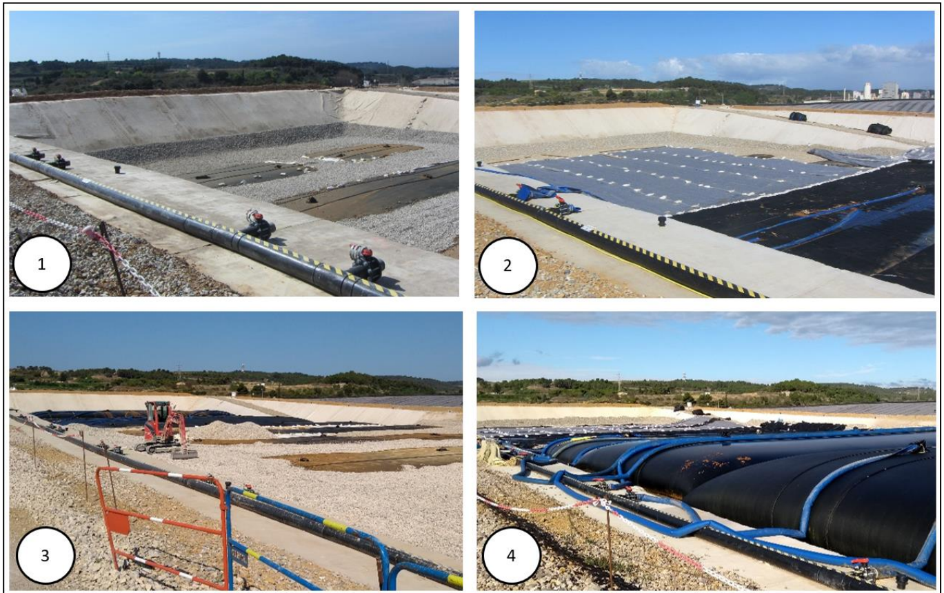
Figure 7. Alvéole PERLE à différents stades de remplissage avec les tubes géosynthétiques
