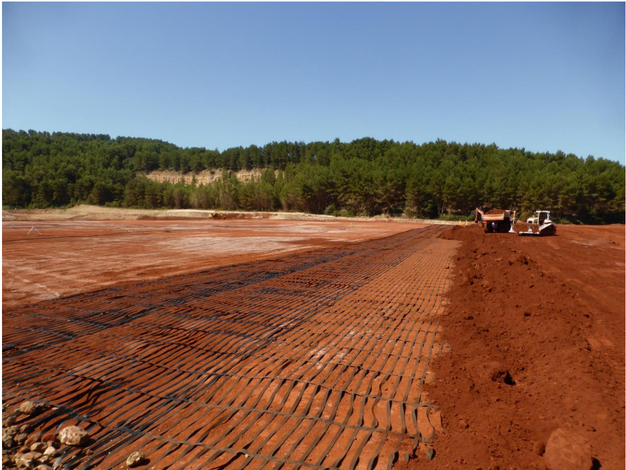
Figure 7. Installation de la géogrille de renforcement
