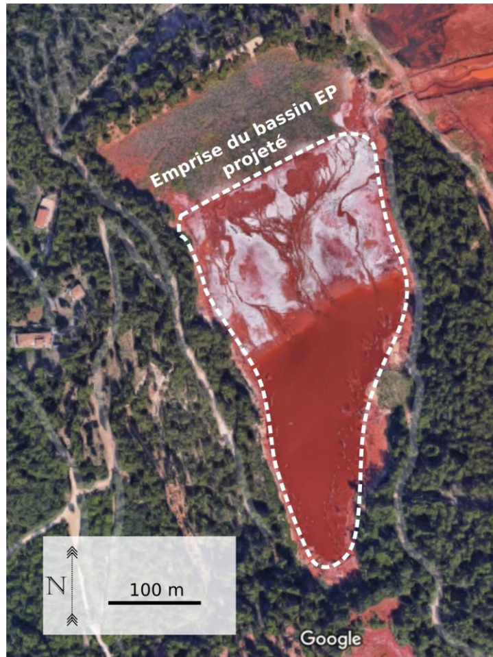
Figure 1. Vue Satellite du bassin B7 du site de Mange Garri. Au Nord du bassin, la plage de dépôt consolidée, et au sud du bassin une zone avec un surnageant sur les boues rouges liquides
