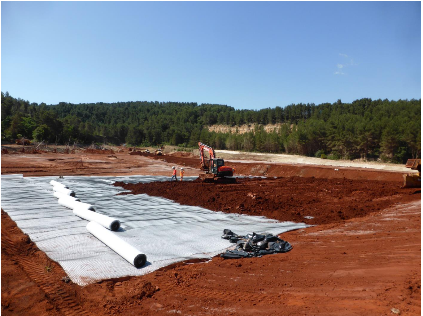
Figure 6. Installation du géocomposite de stabilisation en 2 nappes croisées.
