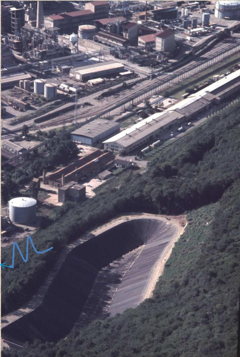
Le réservoir appartient à l'usine chimique, c'est un réservoir de secours en alimentation d'eau.
