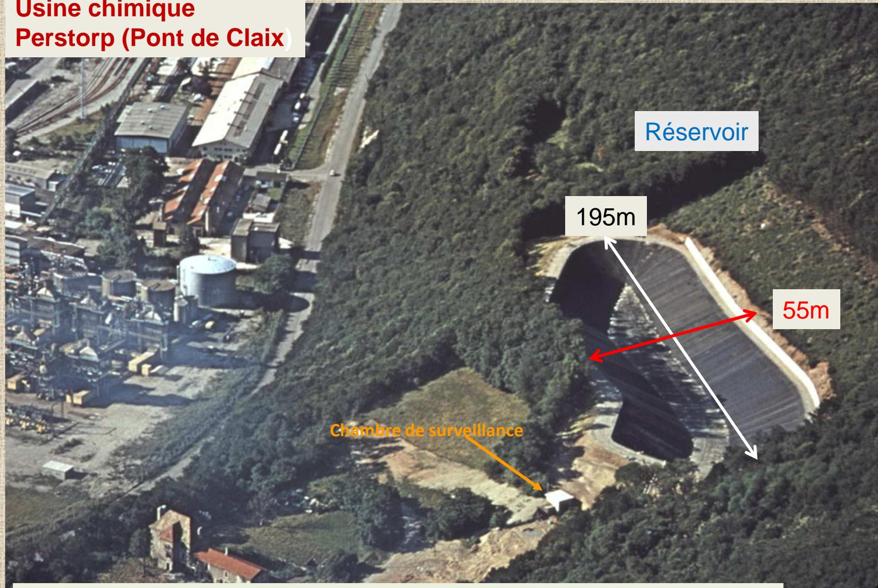
Capacité du réservoir: 40 000m<sup>3</sup> , Vidange en 5h
