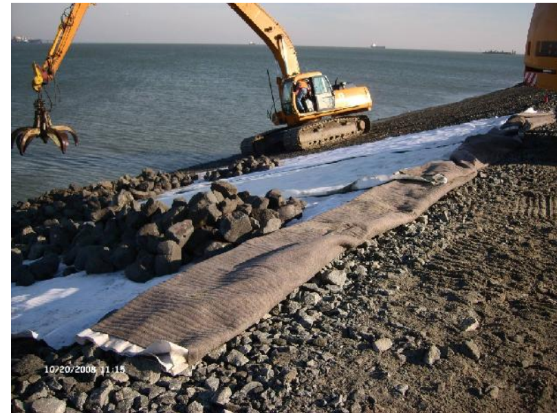
Mise en œuvre et couverture du matelas de sable
