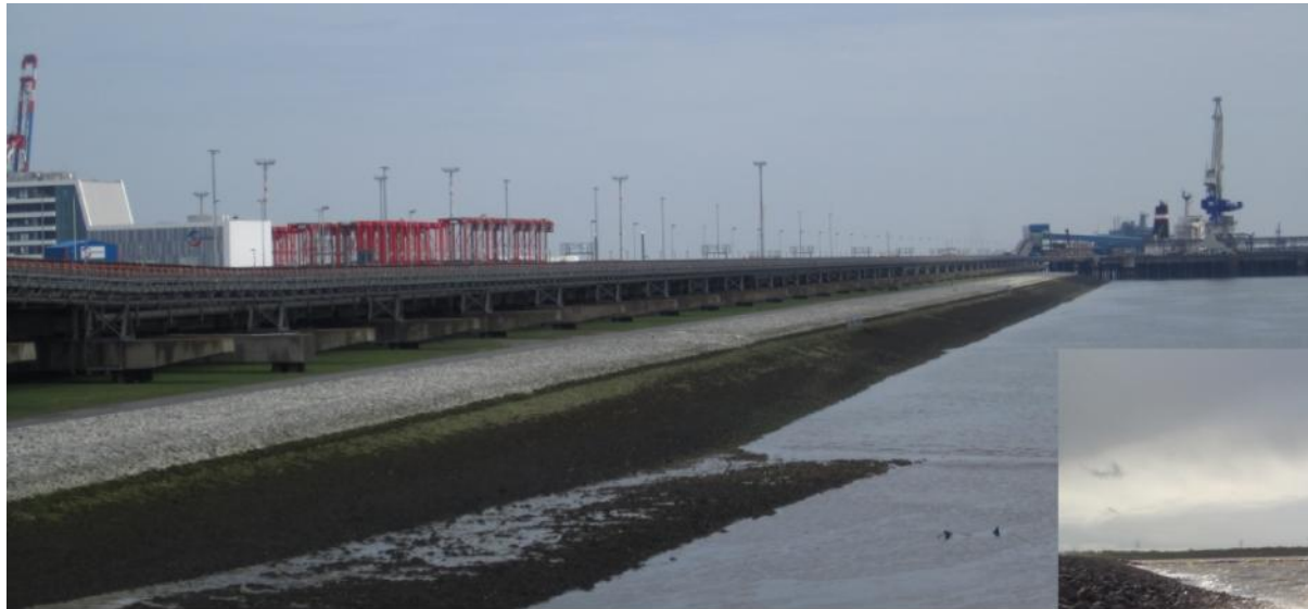
Digue sud terminée
