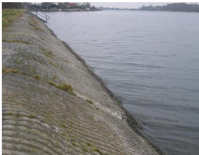
Matelas « pleine surface » mis en œuvre en 1977
