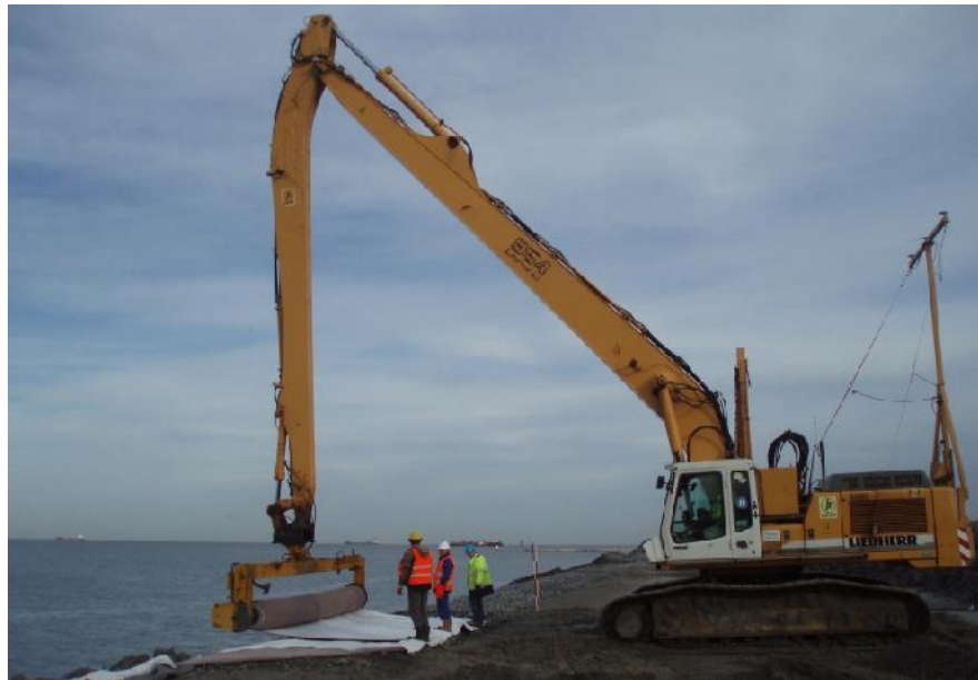
Mise en œuvre et couverture du matelas de sable
