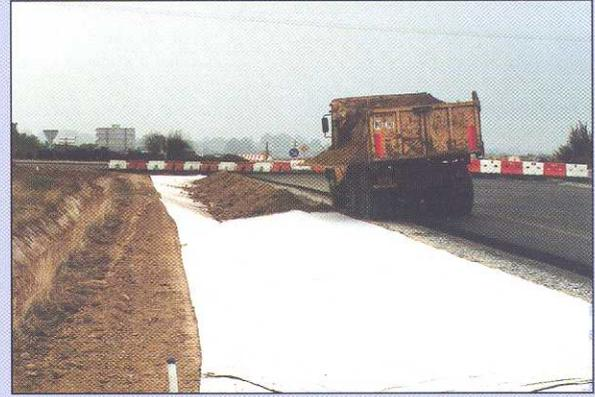
Traitement de l'étanchéité d'un accotement routier
