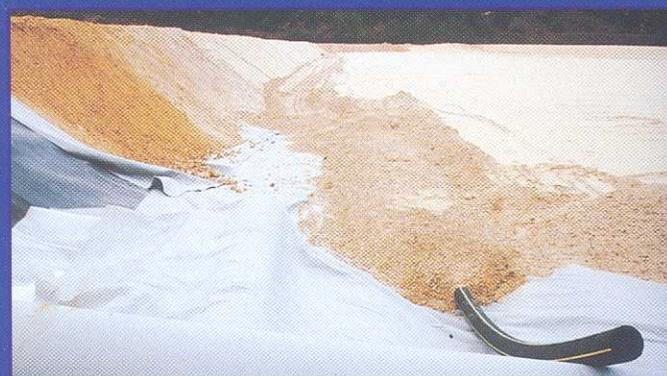
Mise en place de la couche drainante sur la Géomembrane
