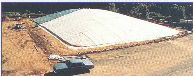
Couverture d'un C.S.D. ( géocomposé bentonitique )
