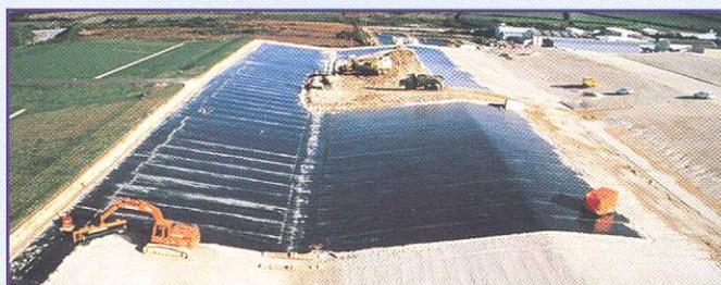
Couverture d'un C.S.D. ( géomembrane bitumineuse )
