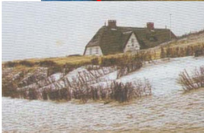
Clôtures servant de piège au sable faites de buissons et oyat
