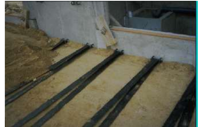
Parement Ecailles béton + bandes géosynthétiques
